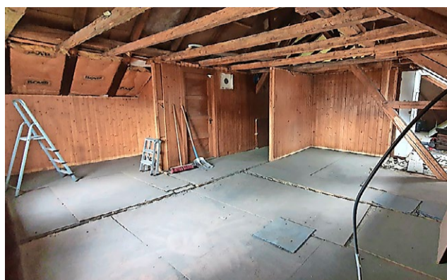
Der Dachstock zu Beginn der Arbeiten.
