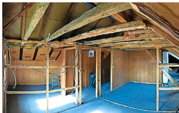
Die Pfeiler für den Einbau der Wände stehen.
