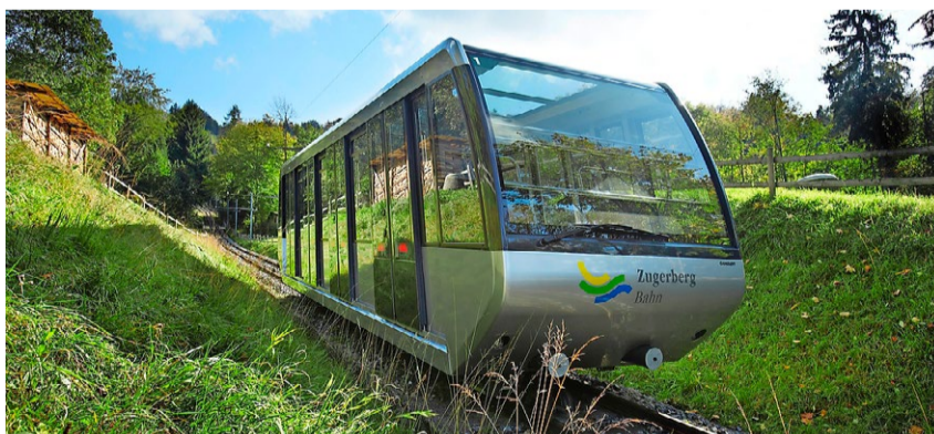
Die Zugerbergbahn wird ab dem 6. April alljährlichen Unterhaltungsarbeiten unterzogen. ZW Archiv
