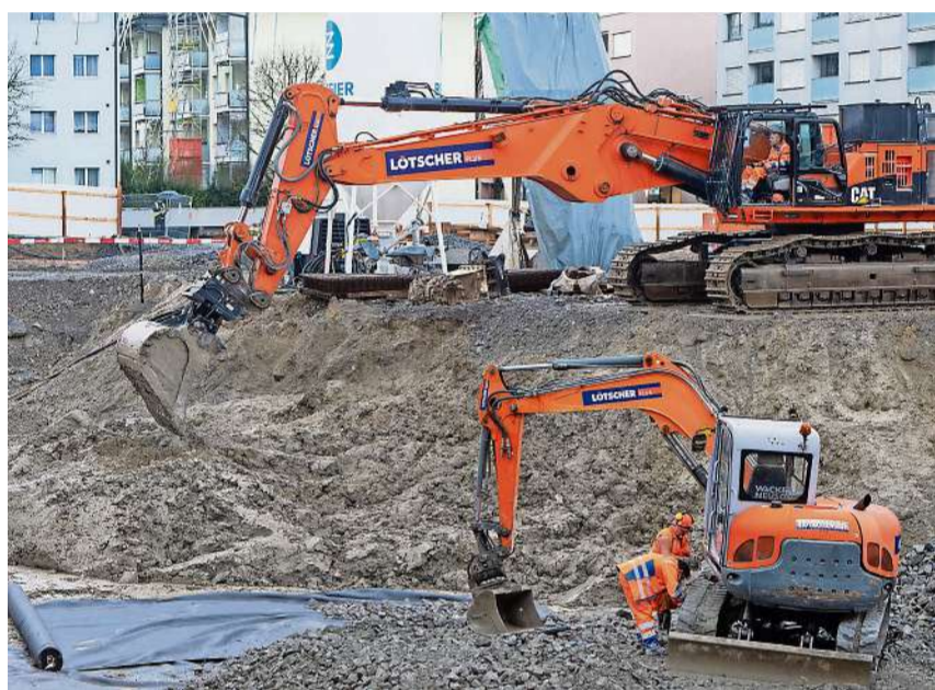
Die Bauarbeiten sind aktuell im Zeitplan. Der Abschluss der Bauarbeiten ist auf Ende 2025 vorgesehen.
