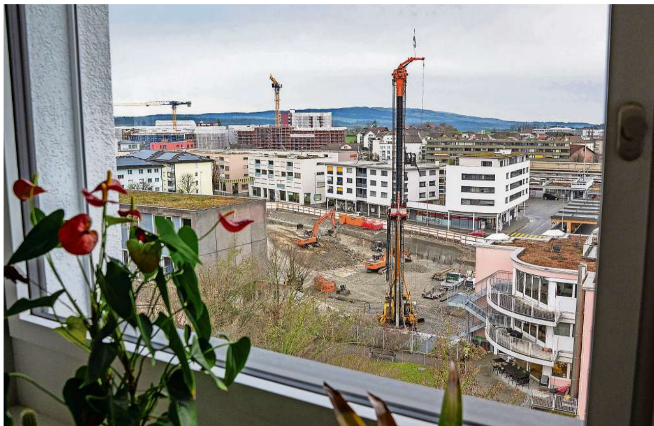
Blick auf die Baustelle Richtung Norden.
