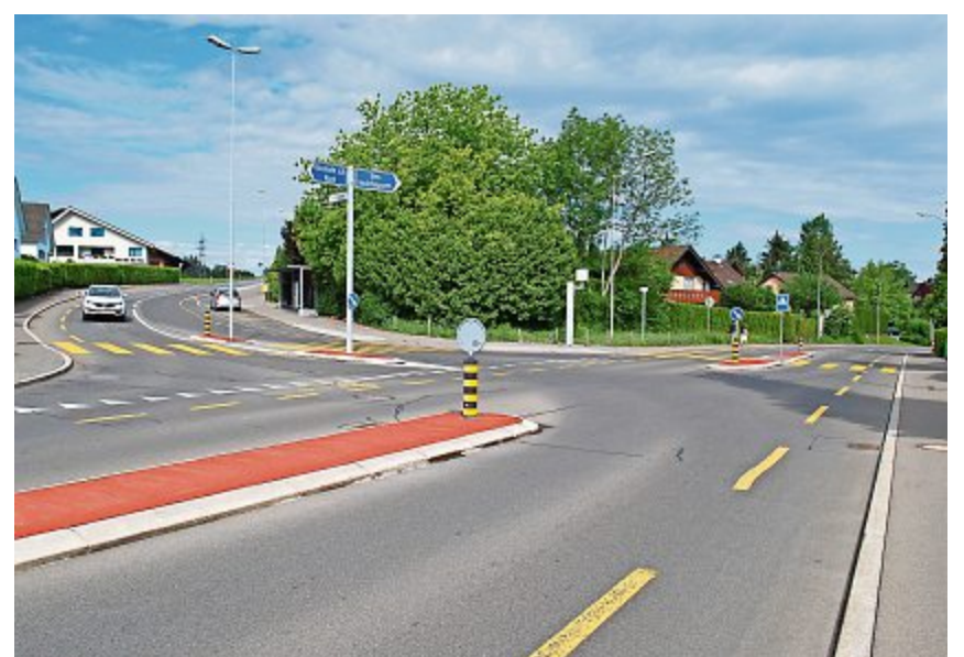
Vom 28. Mai bis zum 8. Juni 2018 wird im Abschnitt Knoten Rischer-/Buonasstrasse die Strasse saniert. Kristina Gysi
